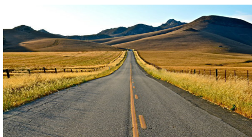
Рис. 5. Пример обнаружения полотна дороги нейронной сетью
